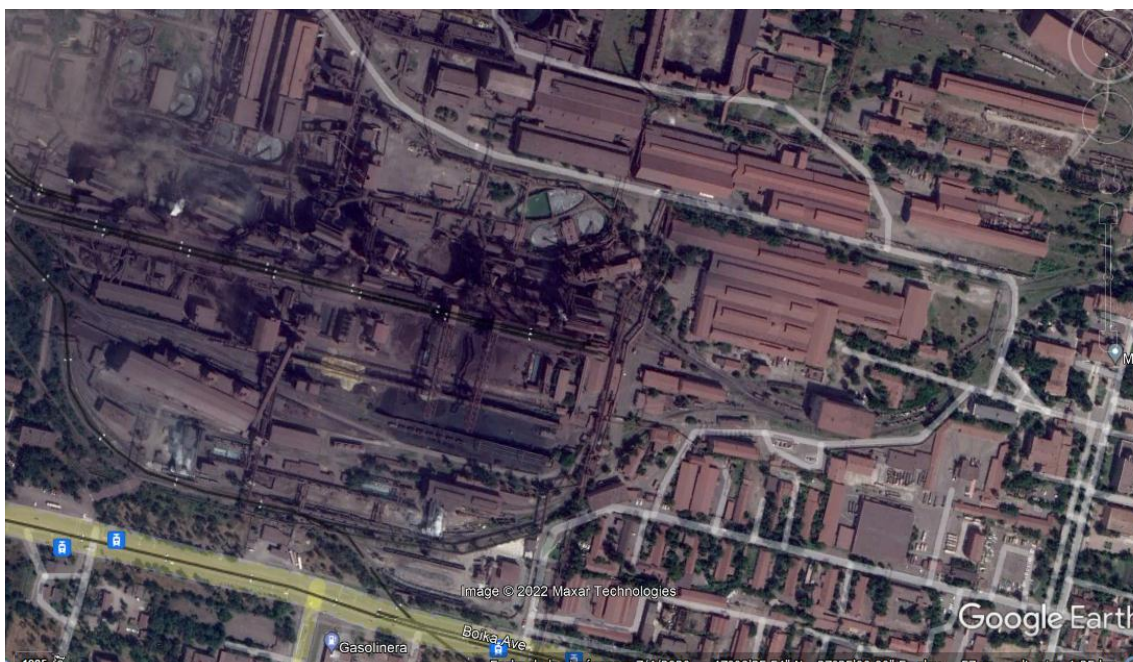
Imagen de Google Earth de la acería Azovstal
